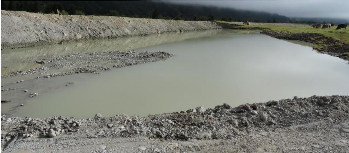
*Hier entstehen die neuen Stillgewässer, die sich auf der Landseite des Damms befinden und mit Grundwasser gefüllt sind. Das hier ausgehobene Material wird auf der Dammkrone eingebaut.*
