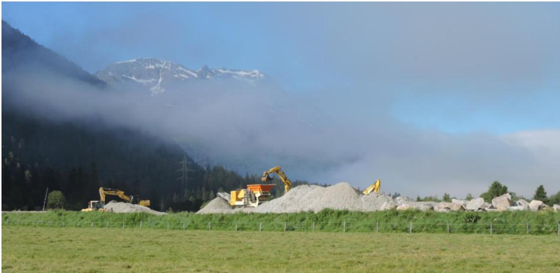
*Maschinen sortieren das Material, das aus dem Aushub der neuen Stillgewässer stammt.*
