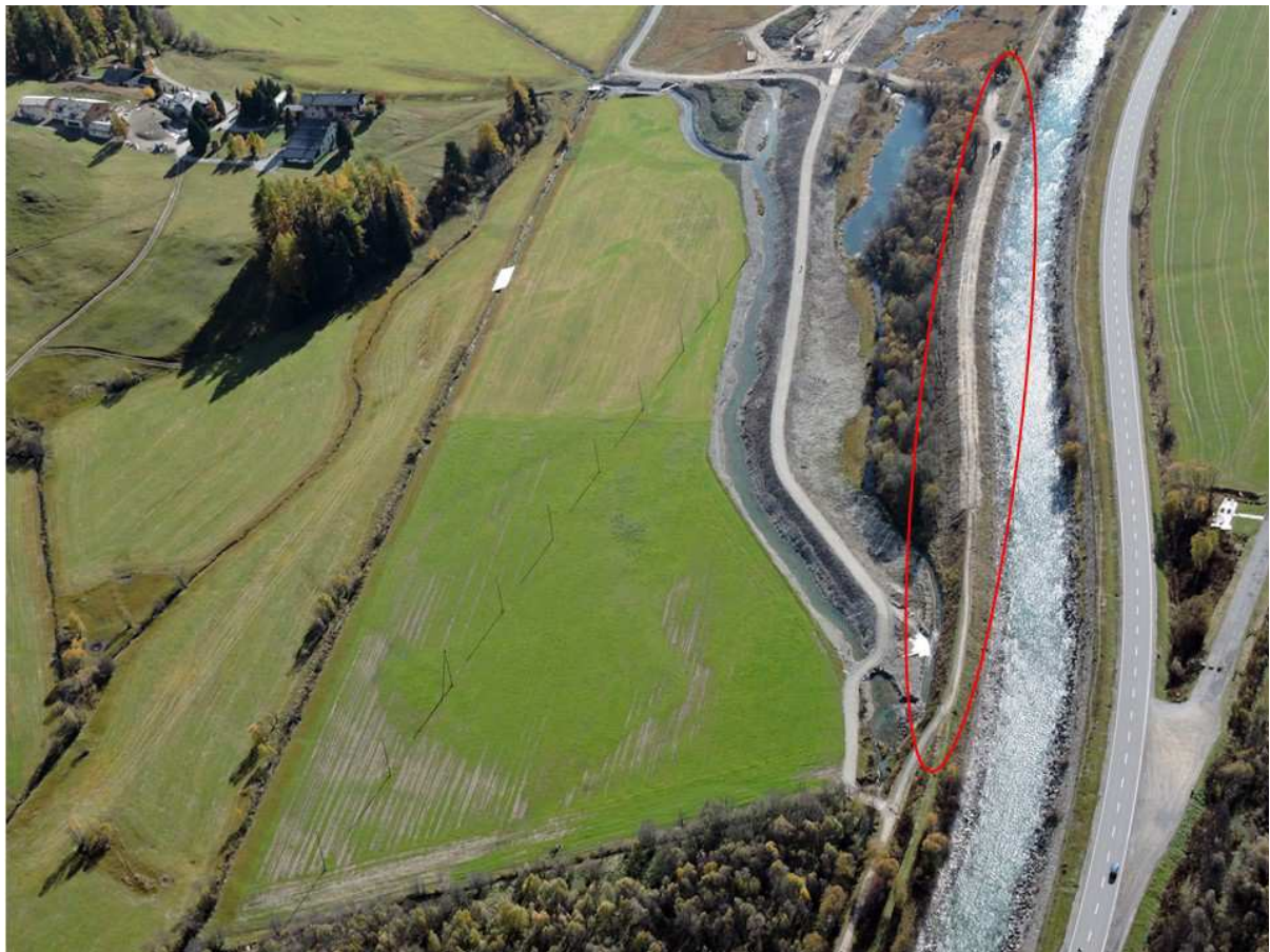
Im untersten Abschnitt haben die Abbrucharbeiten am alten Damm begonnen. Im rot eingekreisten Bereich fehlt zumindest die Dammkrone (Foto: 13.10.18).
