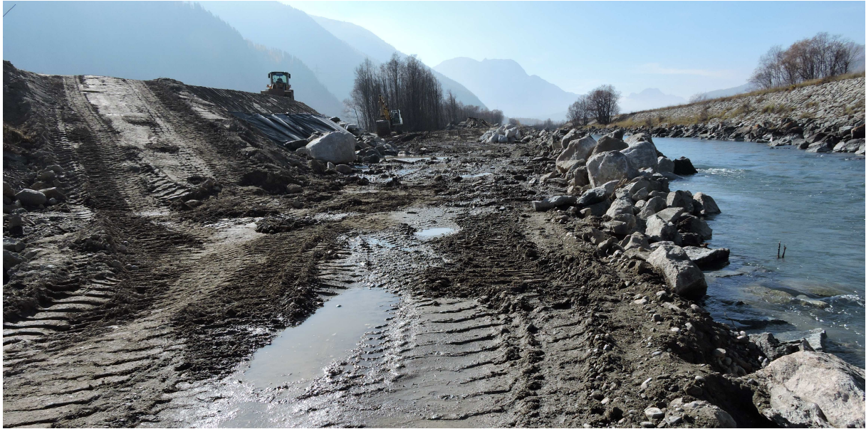
Links im Bild der neue Damm, rechts im Bild der alte Damm auf der Seite gegen die Kantonsstrasse, und in der Bildmitte kein Damm mehr. So präsentierte sich die Baustelle am 26. Oktober 2018.
