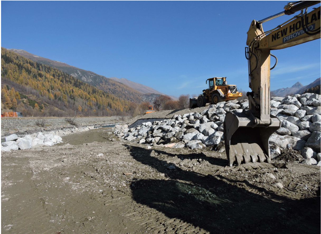
Leider hat die Revitalisierung ein unteres Ende. Hier, mit Blick in Richtung La Punt, ist gut sichtbar, wie der neue Damm (rechts) den Inn zum bestehenden Flussbett hinführt und wieder auf 20 Meter einengt (26.10.18).
