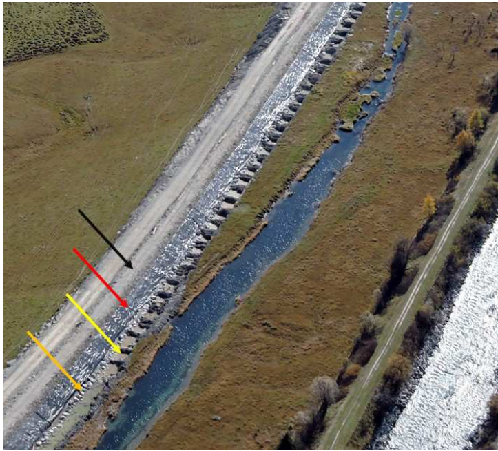
Laufende Arbeiten beim Einbauen des Erosionsschutzes mit interessantem Grabenmuster (Foto: 13.10.2018).
