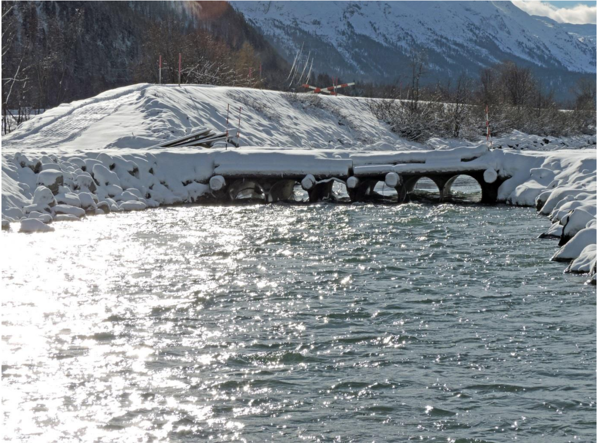
Temporäre Brücke über den Inn, um das Damm-Material von einer auf die andere Seite zu transportieren. Im Hintergrund sieht man den alten rechtsseitigen Damm, das letzte Stück ist bereits abgebrochen (Foto: 8.12.18).
