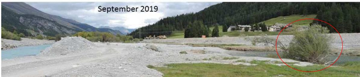
*Die Abbruchfront des alten Damms im Verlauf des Jahres. Rechts im Bild (rot markiert) ist jeweils dieselbe Weide erkennbar. Der Wall links im September-Bild ist zwischengelagertes Material, das vom Entfernen des Damm-Fundaments kommt und auf seinen Weitertransport wartet.*
