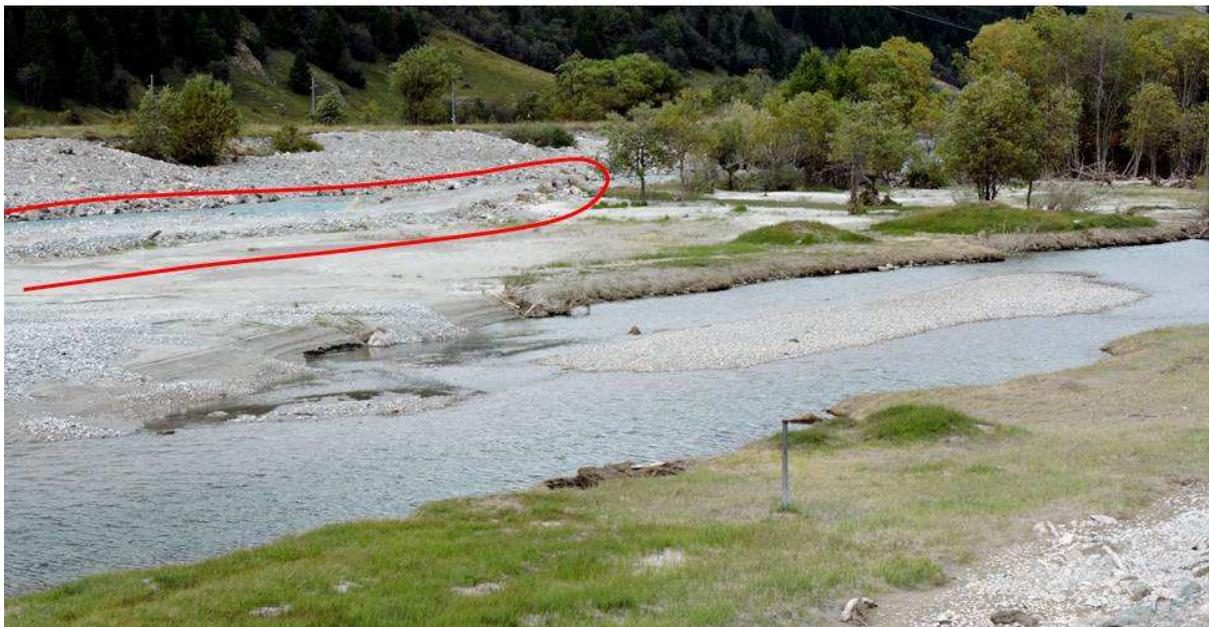
*Die Baupiste (rot markiert) ermöglicht das Entfernen des alten Damm-Fundaments, drängt aber den Inn nochmals in sein altes Bett zurück. Was im Sommer überflutet war, liegt deshalb jetzt wieder trocken (22.9.19).*
