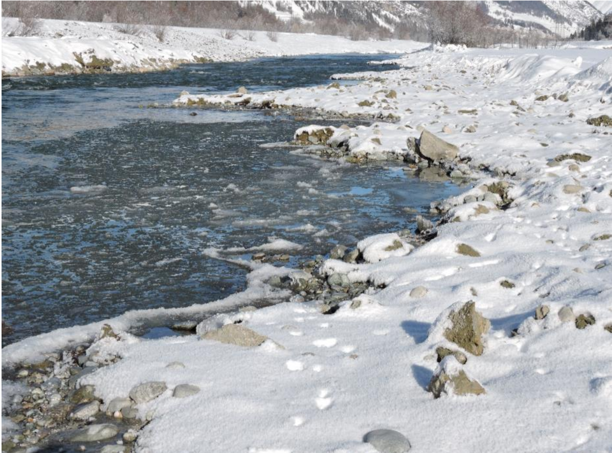
Naturnah gestaltetes, soeben fertig „gebautes“ Innufer im mittleren Teil der Revitalisierung, links sind die Vorschüttungen erkennbar.
