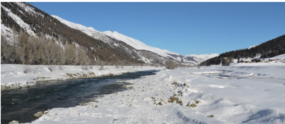
In der linken Bildhälfte der Inn mit seinem flachen Ufer, in der rechten Bildhälfte, praktisch auf der gleicher Höhe, sein erweitertes Flussbett bis zum neuen Damm.
