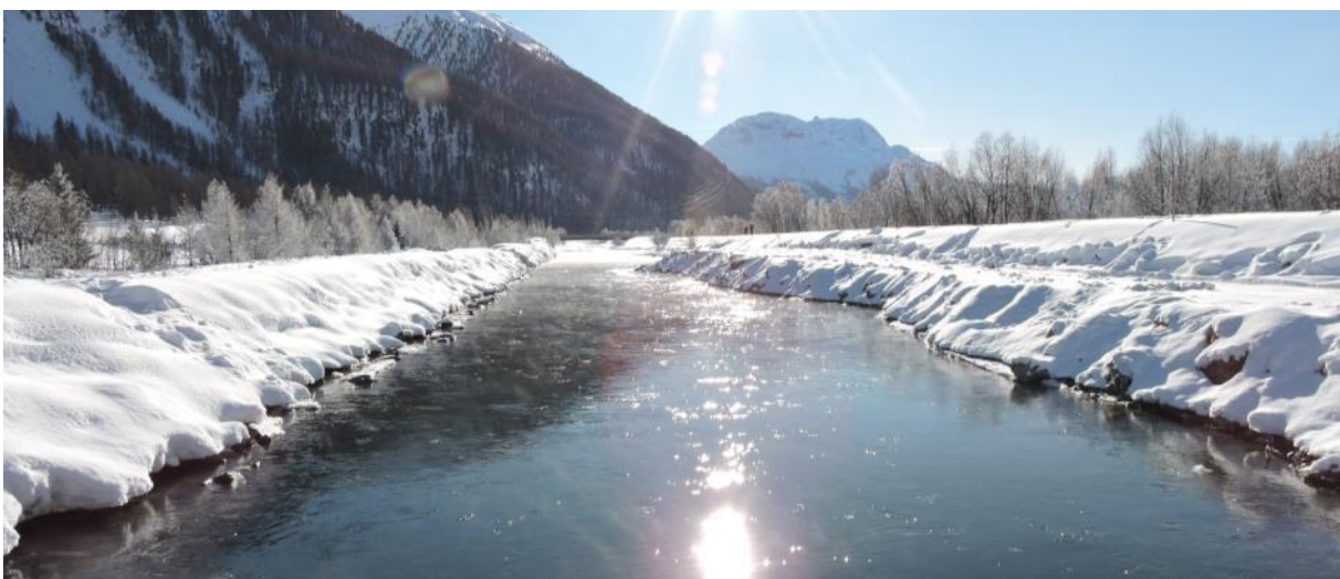
Blick flussaufwärts in den obersten Teil der Revitalisierung. Rechts erkennt man die sich im Bau befindende Vorschüttung mit befahrbarer Piste, links steht der alte Damm noch, wenn auch nicht mehr in der vollen Höhe. Noch hat der Fluss einen geradlinigen Verlauf.
