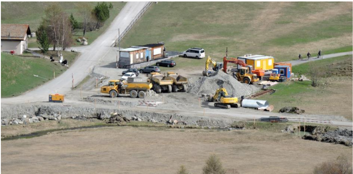
Aus dem Parkplatz Isellas ist eine Baustelle geworden (Foto: 3. Mai 2020).
