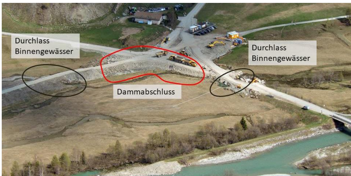
Die Baustelle beim Isellasparkplatz in der Übersicht: Nahtlos geht der neue Damm, von links kommend, in die erhöhte Isellasstrasse hinein (rot umrandet). Die Strasse liegt jetzt bis zu 1.8 m höher als vorher. Das Binnengewässer kreuzt die Isellasstrasse und den neuen Damm (schwarz umrandet; Foto: 10. Mai 2020).
