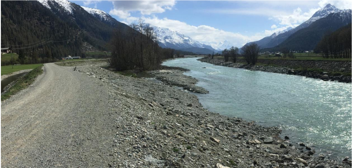
Blick flussaufwärts vom unteren Ende der Revitalisierung: Der Damm macht eine schwungvolle Kurve nach links und vergrössert damit das Flussbett massiv (Foto: 10. Mai 2020).
