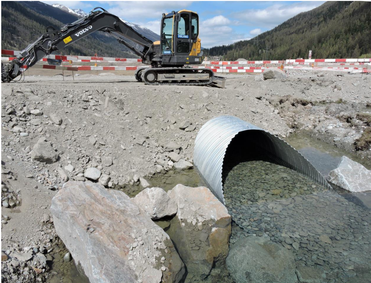
Dieser frisch eingebaute Durchlass leitet das Binnengewässer fischgerecht unter der Isellasstrasse hindurch (Foto: 10. Mai 20).
