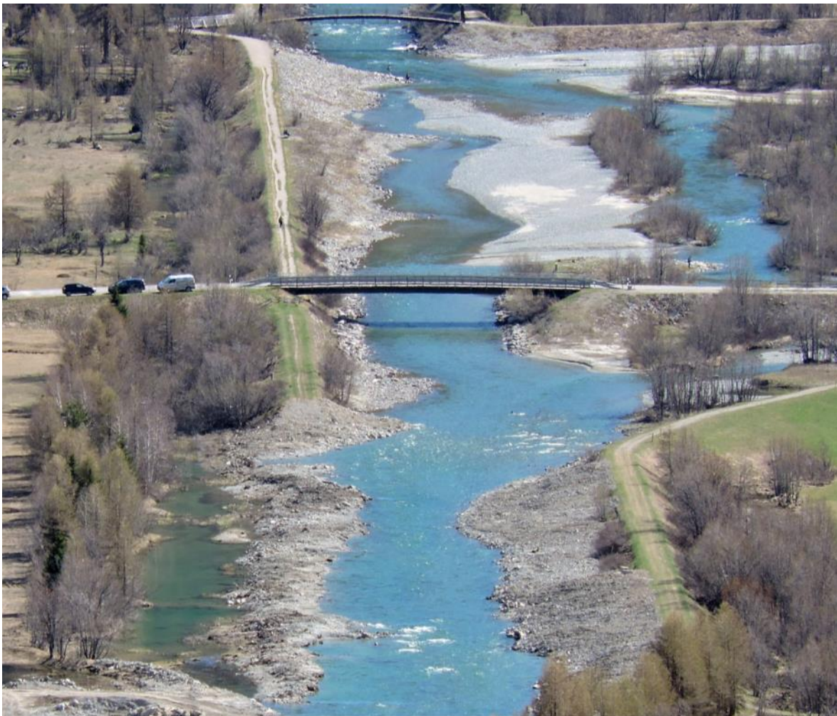
Blick von der Via Engiadina aus auf das letzte Stück des alten Damms. Gut zu erkennen sind die Vorschüttungen am bestehenden Damm (Foto: 3. Mai 2020).
