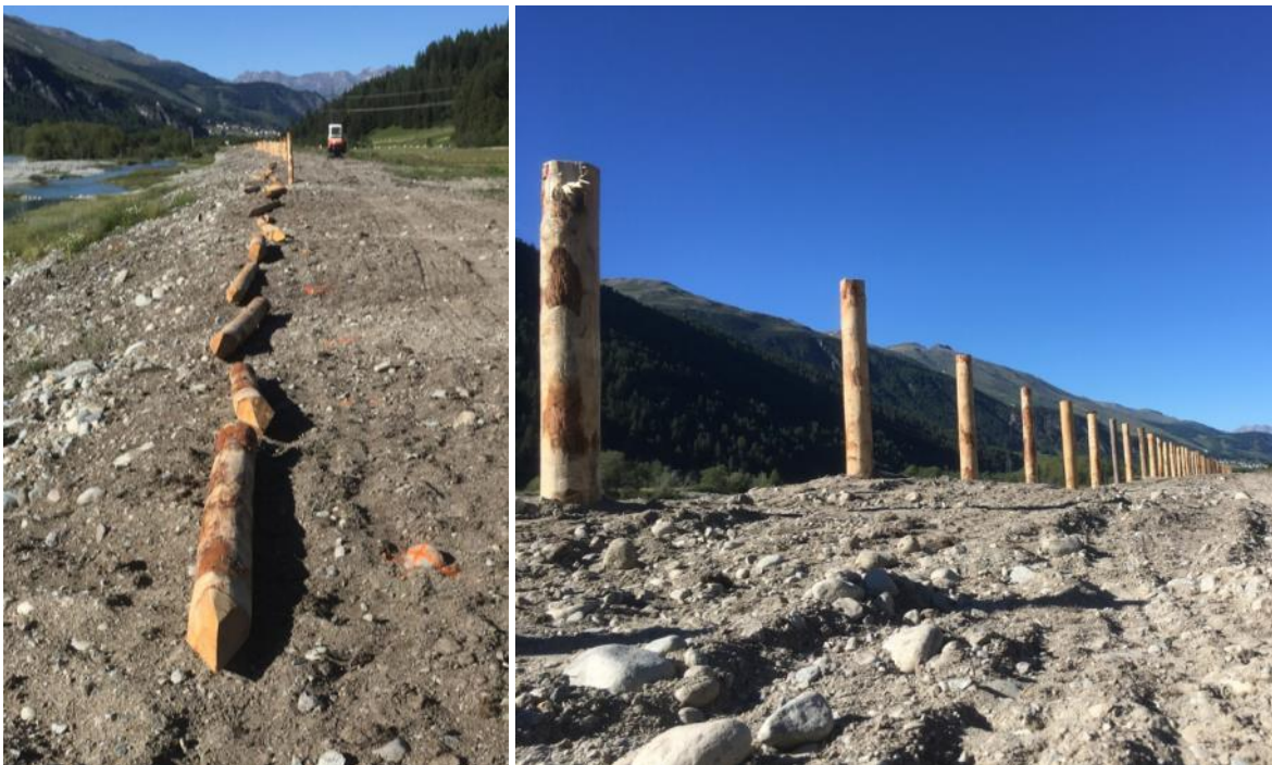
Holzpfahl um Holzpfahl, bereitgelegt, aufgerichtet und in einer langen Reihe eingeschlagen, fügen sich schliesslich zum neuen Weidezaun zusammen (7. Juli 20).
