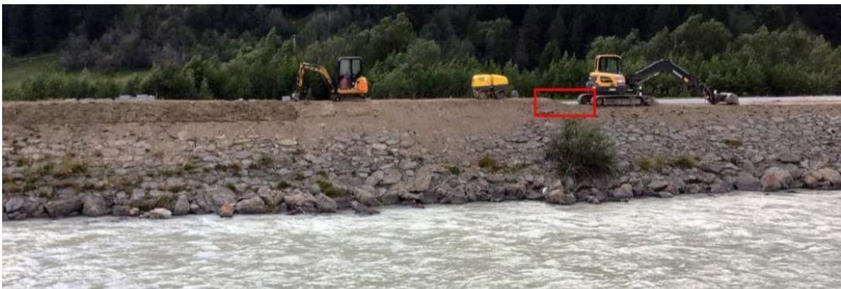
Im roten Rechteck ist die Dammerhöhung sichtbar (29.7.20).
