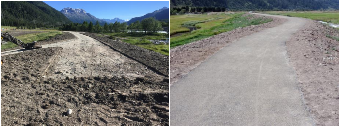
Links: Die Vorbereitungen für den befestigten Weg auf der Dammkrone haben begonnen (7. Juli 20). Rechts: Der fertige Weg lädt ein zum Spazieren oder Radfahren (29. Juli 20).
