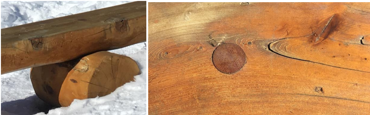
Die Füsse der Sitzbänke sind mit einer Gewindestange verbunden, die unter dem Holzapfen versteckt ist (Foto: C. Levy)
