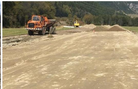
Links: im Vordergrund sieht man die erste, verdichtete Schicht. Der Dumper im rechten Bild fährt zurück zur Zwischendeponie, um neues Erdreich zu holen.
