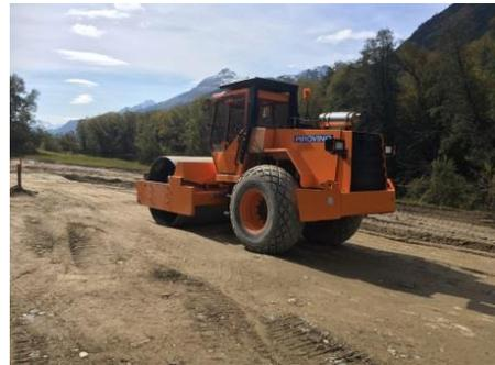
Über das Bewehrungsvlies kommt die erste Schicht Schüttmaterial zu liegen. Die Walze verdichtet anschliessend das feinkörnige Material, bis es genügend dicht ist.
