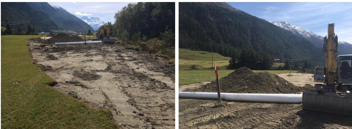
*Links: Abhumusierter Boden für den neuen Damm. Rechts: Das ausgerollte Vlies verstärkt die Fundation, dahinter liegt bereits Material für die erste Schicht des Damms.*
