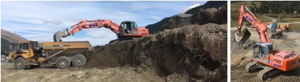
*Der Bagger schaufelt den in den letzten zwei Jahren gesammelte, saubere Aushub von der Zwischendeponie auf die Dumper, welche damit zur Verwendungsstelle beim neuen Damm fahren.*
